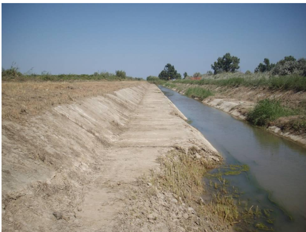
Canale dopo l'intervento di pulizia, 29.07.2009 (foto S. Sgross)
